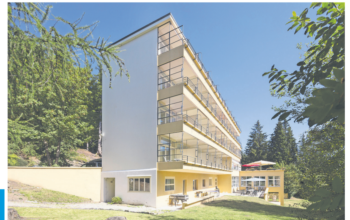
Montana. Das ehemalige Sanatorium «Bella Lui» (Rudolf Steiger, Flora Steiger-Crawford, Arnold Itten, Otto Senn, 1930) in Montana ist L-förmig angelegt. Das vom Bauhaus-Stil beeinflusste Gebäude ist ein historisches Denkmal nationaler Bedeutung. * ETAT DU VALAIS/SIP © THOMAS ANDENMATTEN
