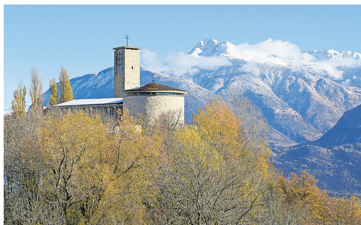
Chermignon d'en-Haut. Die Isolierung der Kirche Saint-Georges (Jean-Marie Ellenberger, 1953) in Chermignon d'en-Haut verstärkt die Wirkung einer modernen Architektur, die Materialien geschickt kombiniert. *
