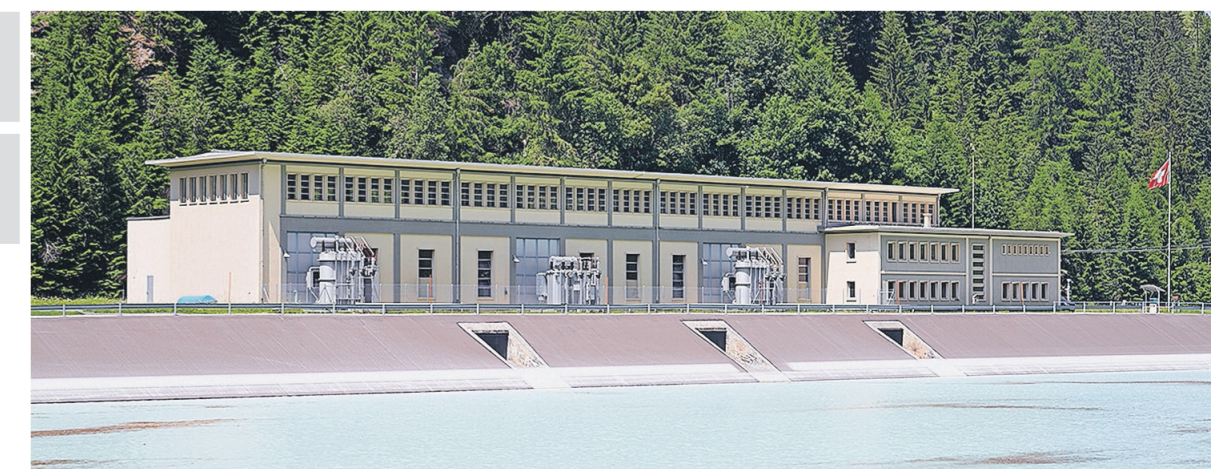
Val d'Anniviers. Das Wasserkraftwerk Mottec (André Perraudin, 1958) im Val d'Anniviers ist ein kleiner Wasserkraftkomplex mit rechteckigem Grundriss, der sich durch Bescheidenheit und Eleganz in seinem Volumen und seiner Architektur auszeichnet.*
