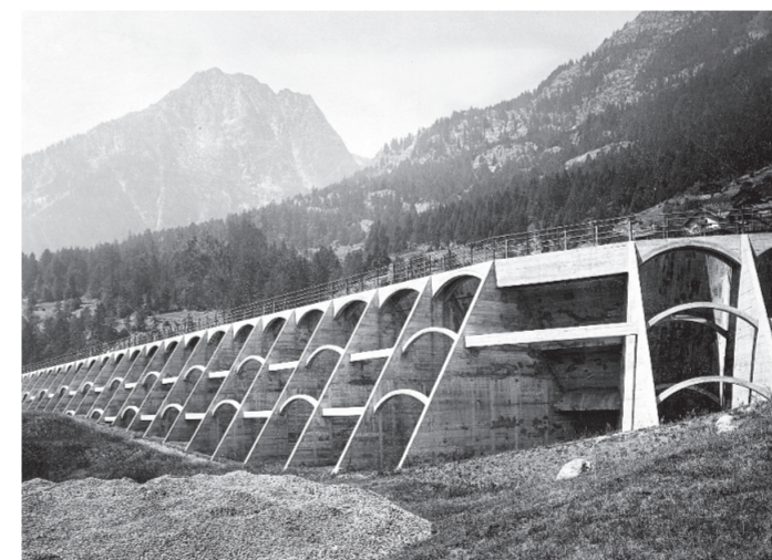
Les Marécottes. Dieser Staudamm (Alexandre Sarrasin, 1926) stellt zum Zeitpunkt seiner Errichtung eine echte Innovation dar. Seine 12 cm dicken Gewölbe aus Spritzbeton breiten sich wie zarte Spitze über die Hochebene von Les Marécottes aus.*
