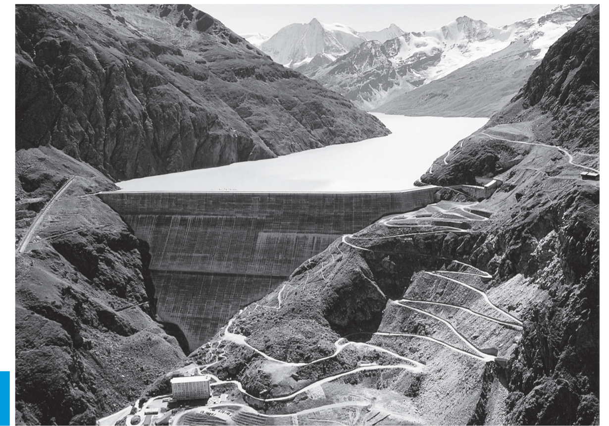
Val des Dix. Die mit 285 m höchste Gewichtstaumauer der Welt, die Grande Dixence (Alfred Stucky, 1950–1961), ist eine mächtige Betonkonstruktion, die aus einer titanischen Baustelle in der unfreundlichen Umgebung eines Talbodens hervorgegangen ist.*
