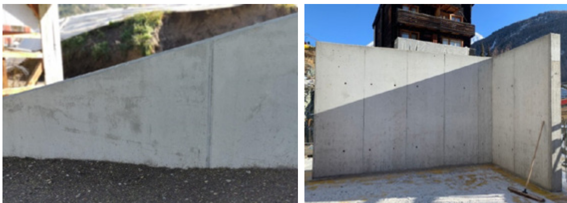
FIGURE 5.1 - EXEMPLES DE MURS EN BÉTON DE RECYCLAGE RC-C: MUR DE SOUTÈNEMENT POUR UN PRIVÉ ET MURS D'UNE ÉCOLE. Photos du groupe Volken.
