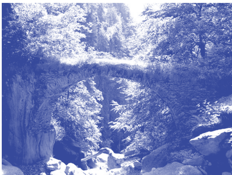
VIII Le Vieux-Pont avant sa restauration en 2008
