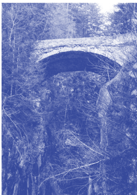
X Vue du pont routier, 2020
