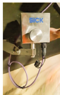
Dieses Gerät misst den Luftstrom. Cet appareil mesure l'écoulement de l'air
