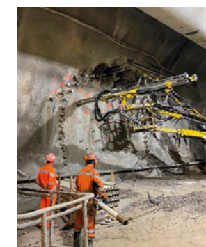
Amorce de la galerie de secours en voûte parapluie Beginn des Nottunnels in einem Schirmgewölbe
