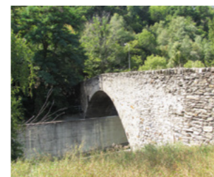
Aktuelles Foto der Brücke, 2021 Photo actuelle du Pont, 2021
