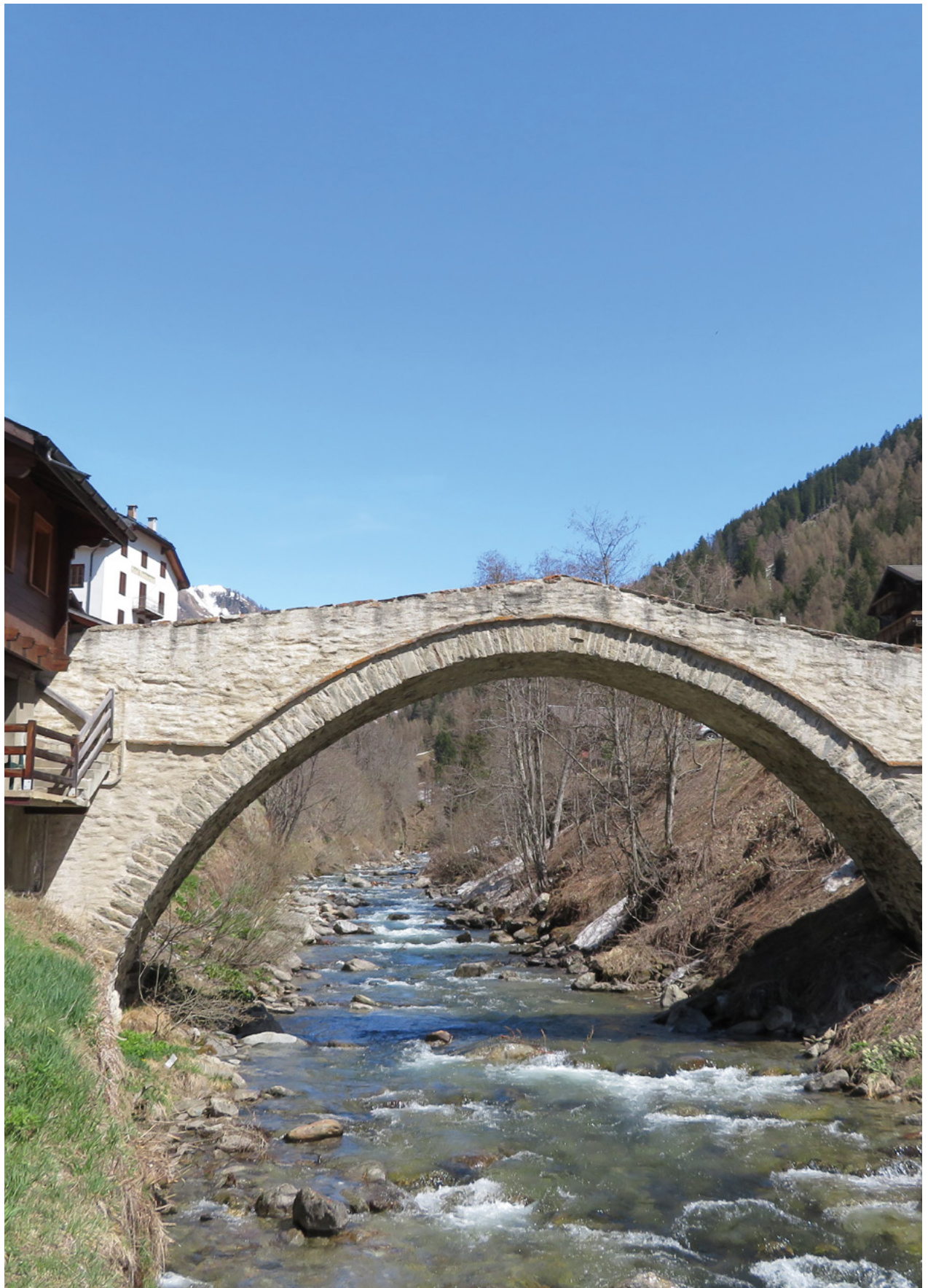
Brücke in Binn aus dem Jahr 1564. Pont situé à Binn datant de 1564
