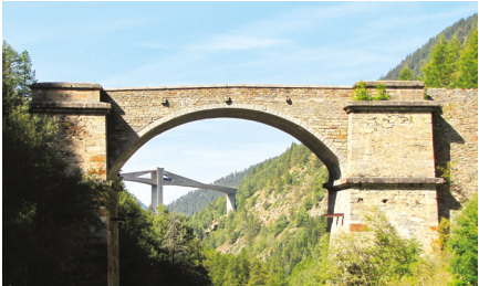
4. Martigny Heutige Ansicht der alten Ganterbrücke, 2020, Guillaume Papilloud Vue actuelle de l'ancien pont du Ganter
