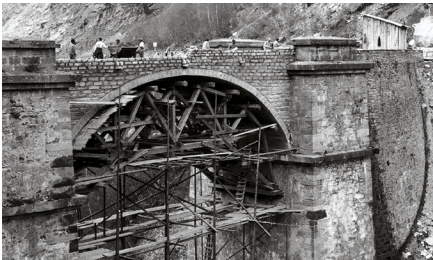
3. Sprengung der Ganterbrücke, 8. März 1933. Ponts et chaussées, Mediathek Wallis – Martigny Dynamitage du pont du Ganter, 8 mars 1933
