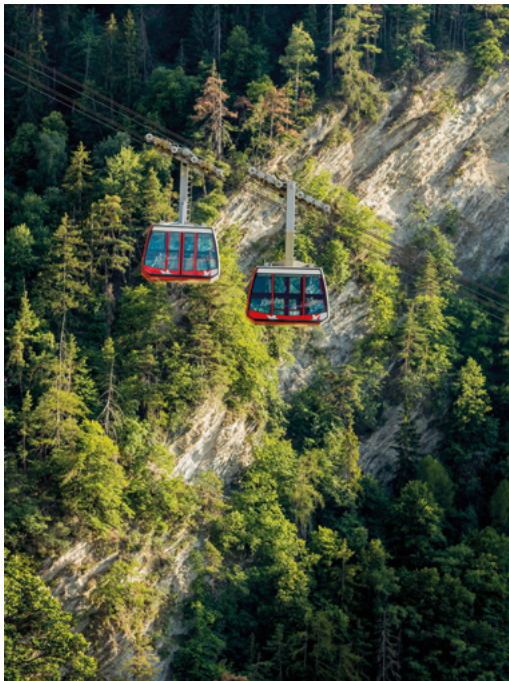
Les nouveaux téléphériques d'Isérables Die Seilbahnen von Isérables
