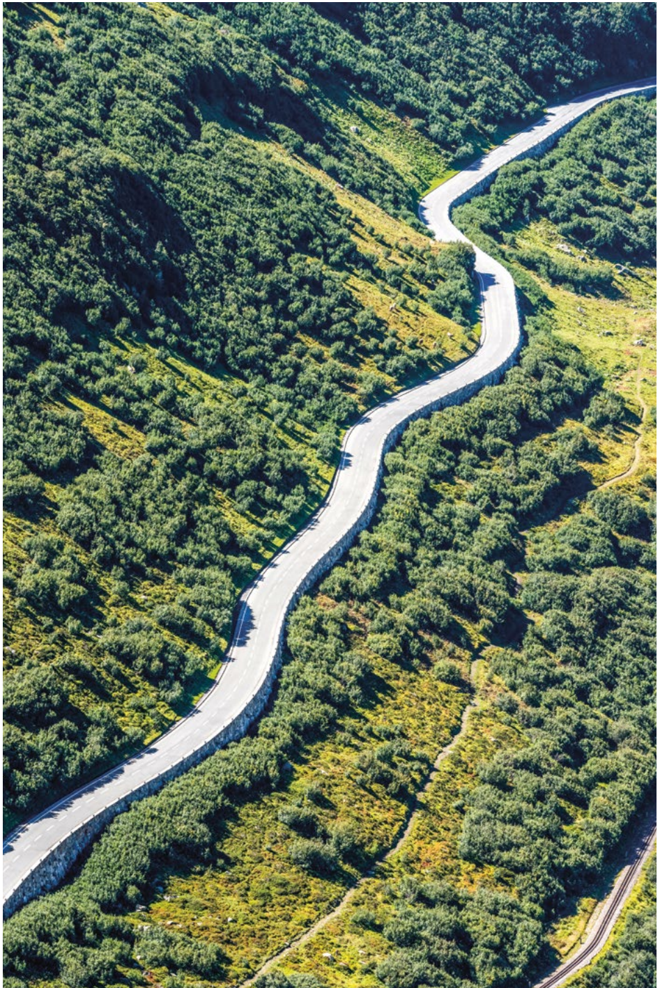
Route de la Furka / Furkastrasse
