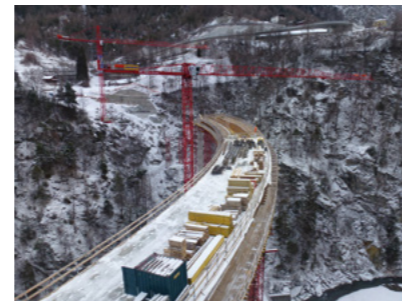
Die Brücke Chinégga mit ihrem künftigen Widerlager Süd im Hintergrund
