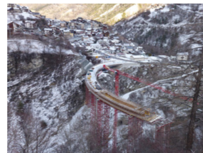
Brücke Chinégga Übersicht
