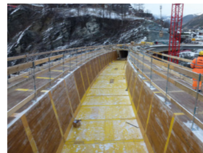
Brücke Chinégga Schalung der 3. Etappe des Brückenträgers
