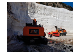
Die Gerätschaften waren stetig im Grenzbereich. Belegschaft von 30 Personen im Einsatz
