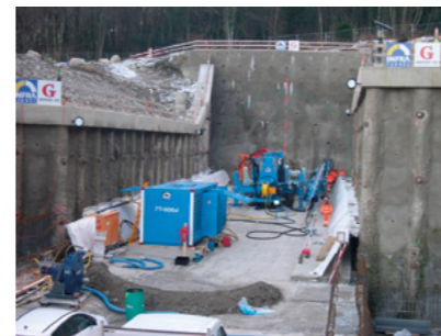
Foreuse pour jetting au front d'attaque du portail nord
