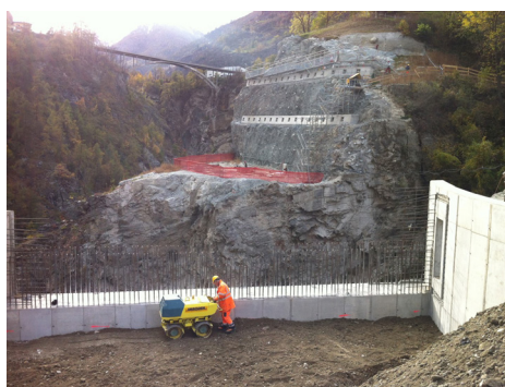
Avancée des travaux de Stalden
