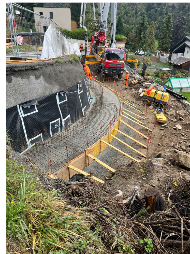
Fondation pour le mur de l'aire de retournement 1 | Fundament für die Mauer des Wendeplatzes 1
