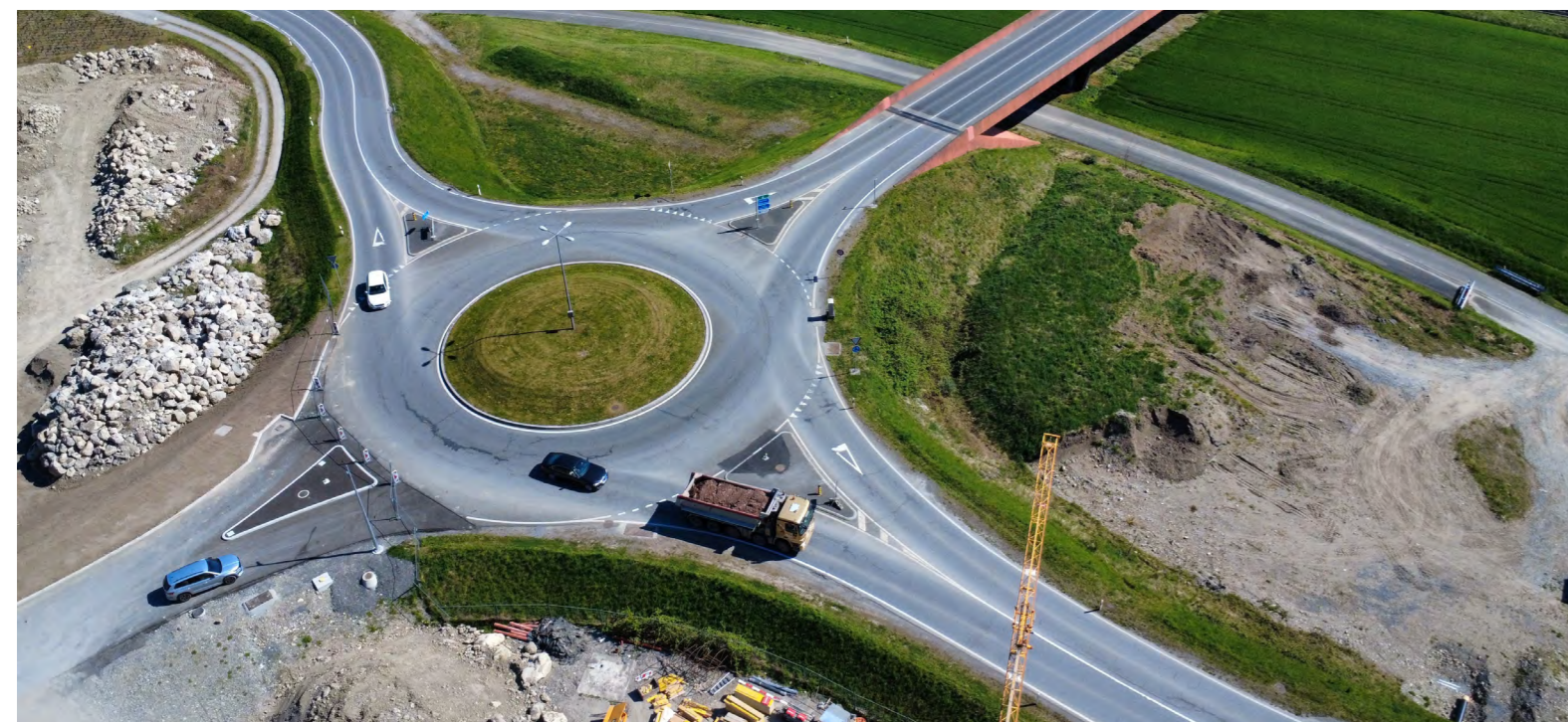
Giratoire au portail sud du Tunnel des Évoettes | Kreisels beim Südportal des Tunnels Les Évoettes
