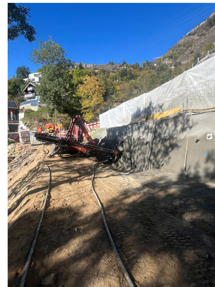
Mur cloué à l'aire de retournement 2 | Nagelwand am Wendepplatz 2
