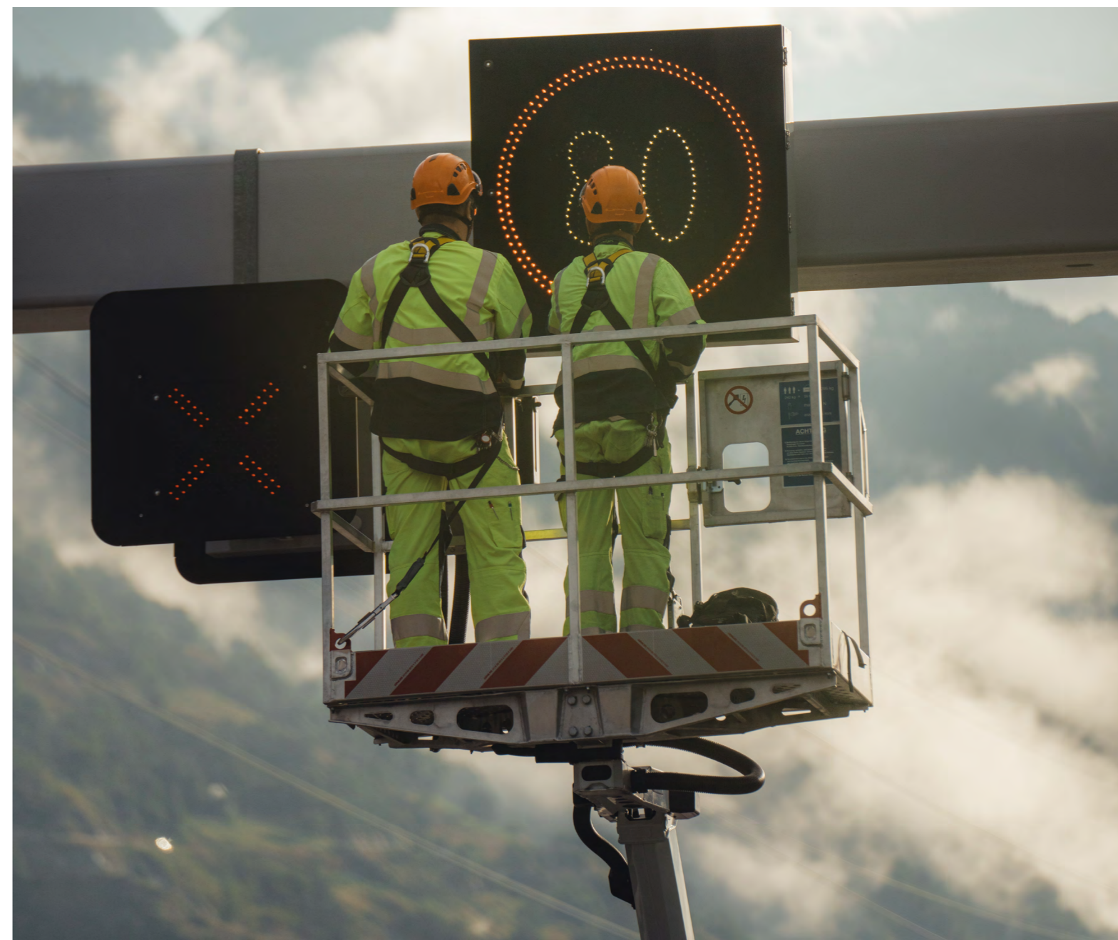
Dépannage sur un panneau de limitation de vitesse par les électriciens du SUTIII | Reparatur einer Geschwindigkeitsanzeige durch die Elektriker des DGEIII
