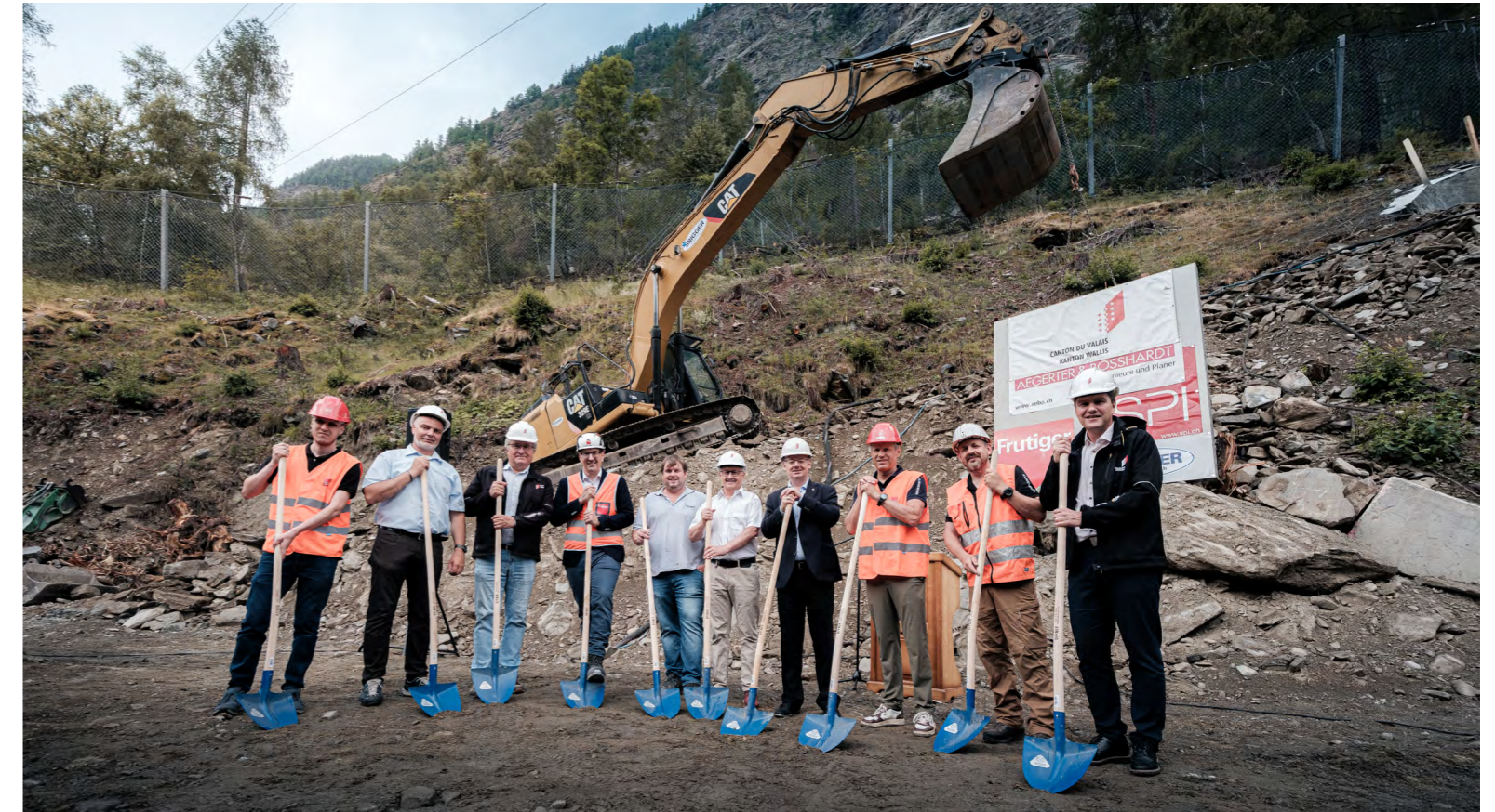
Premier coup de pelle à Deibfels | Spatenstich Tunnel Deibfels
