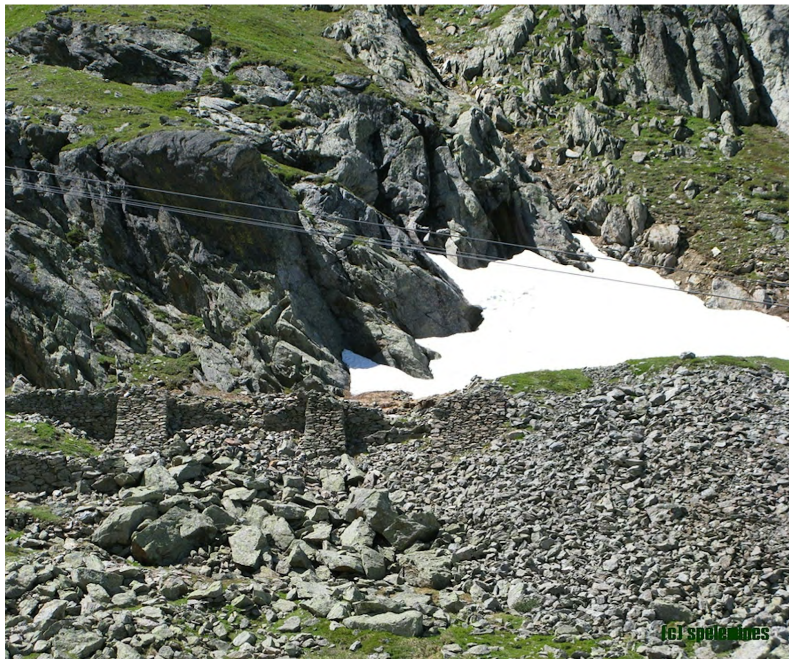
Menouve Suisse, Vestiges du Chantier, Association Spélémines | Menouve Suisse, Überreste der Baustelle, Vereinigung Spélémines
