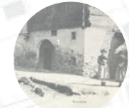
rue cantonale, parfois occupée par des processions source: Fondation Breizh-Héritier
