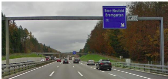
Support du signal par-dessus la chaussée
