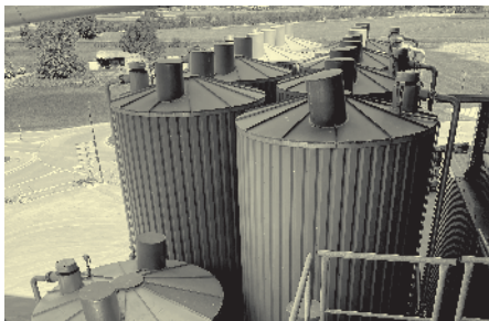
Les silos / cuves à bitume.
