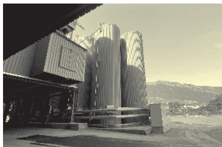
Les silos d'enrobés, avec à gauche le passage pour les camions.
