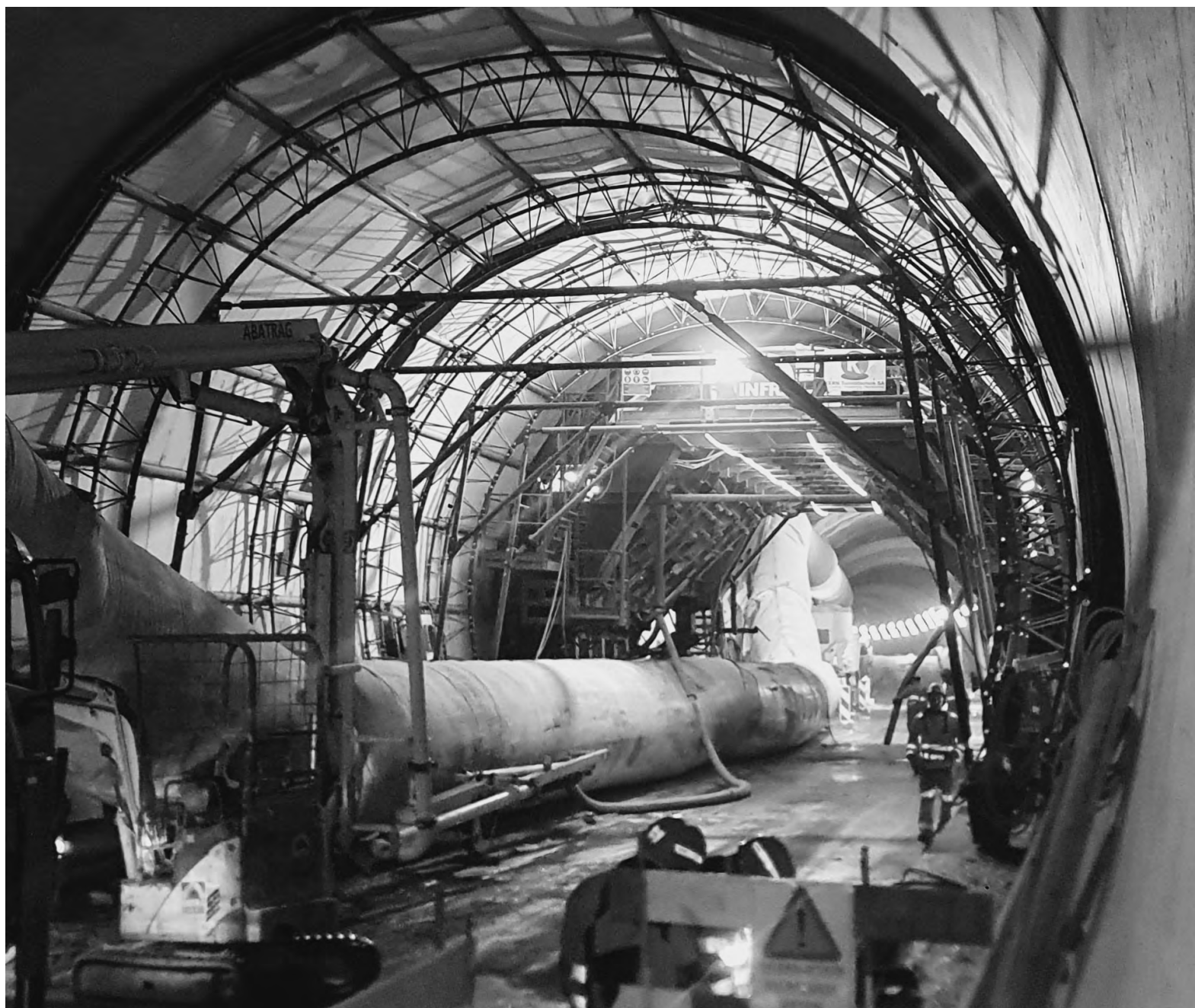
Tunnel des Evouettes | Der Tunnel von Les Evouettes
