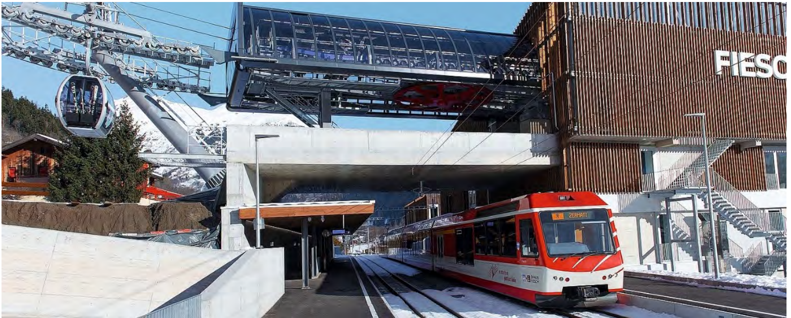
Interface rail-câble à Fiesch (image Garaventa) | Schiene-Kabel-Schnittstelle in Fiesch (Bild Garaventa)
