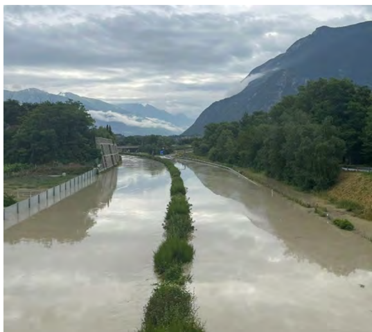
Débordement du Rhône sur l'A9 à la hauteur de Sierre (2024) | Überschwemmung der Rhone auf die A9 bei Siders (2024)
