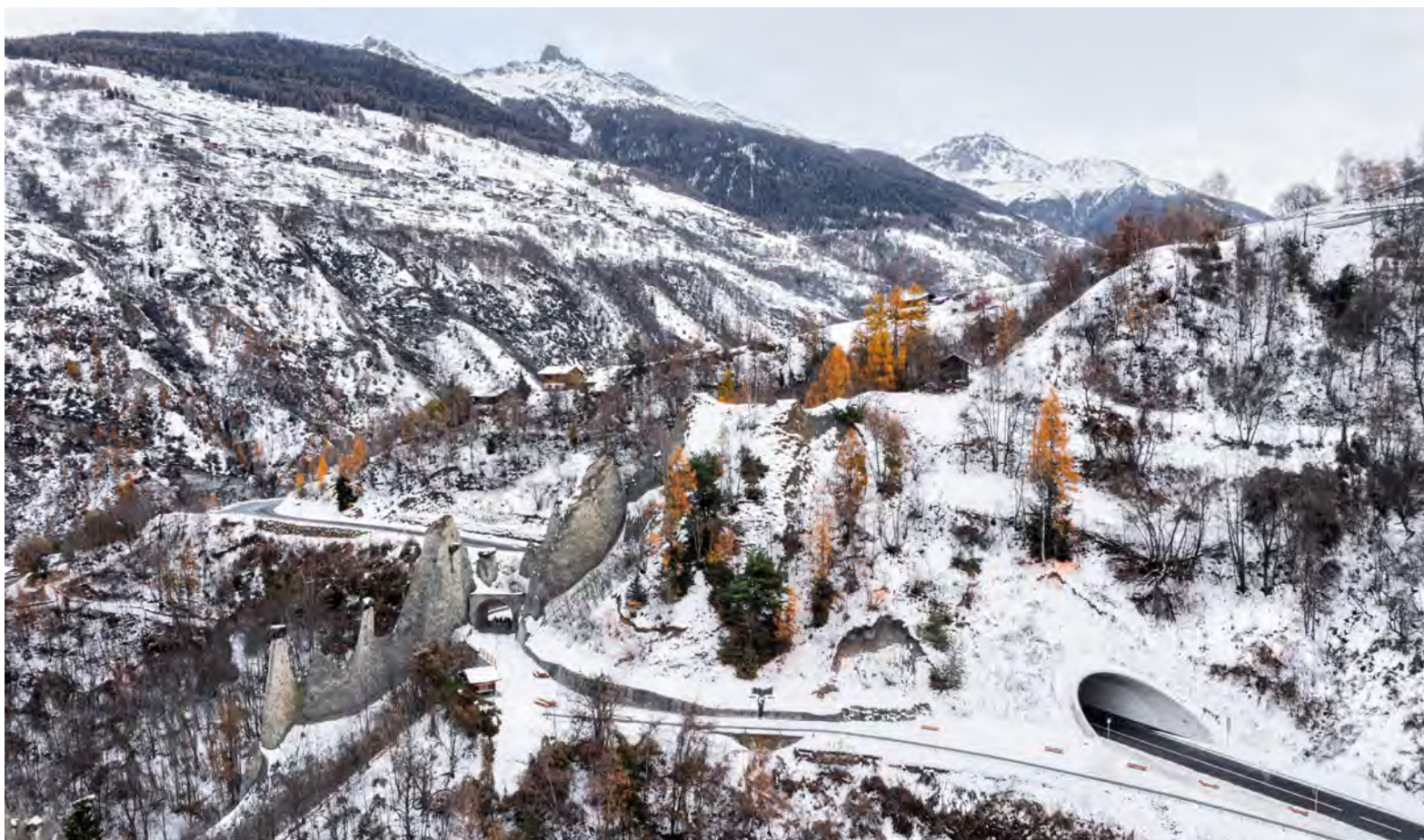
Tunnel des Pyramides d'Euseigne © Nicolas Sedlatckeh Photographie | Tunnel der Pyramiden von Euseigne © Nicolas Sedlatckeh Fotografie
