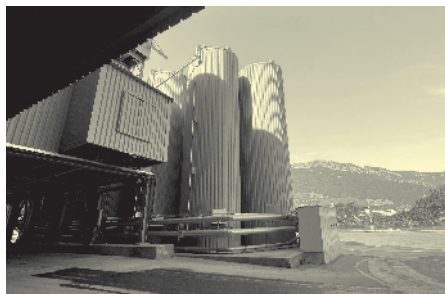
Die mit Belägen gefüllten Silos und links der Durchgang für die Lastwagen.
