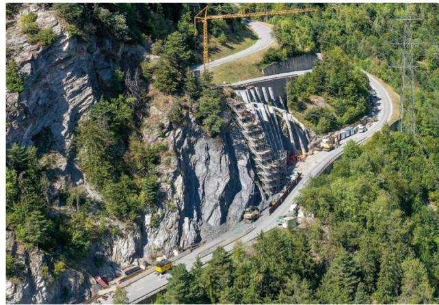
de roches meubles recouvrant un schiste noir très incliné, appelé schiste d'Aalénien. Plusieurs systèmes de plans de faille traversent la roche en place. Pour le déroulement du glissement de terrain, la schistosité principale et les fissures existantes sont déterminantes.
