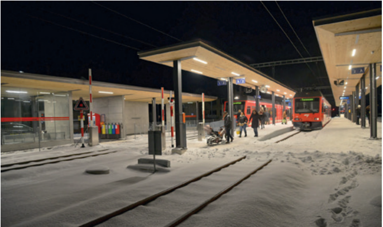
Figure 8 – Gare du Noirmont : la traversée en surface a ici été acceptée (un PI existant a également été maintenu dans le cadre du réaménagement de la gare) avec une installation de sécurité (barrières et signaux) ; tous les trains s'arrêtent en gare (deux lignes diamétrales et une troisième en terminus).
