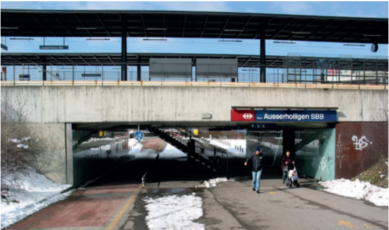
Figure 9 – Gare d'Ausserholligen : pas de conflit entre liaison verticale et vélos (qui passent sous l'escalier) pour ce passage inférieur sans dénivelé
