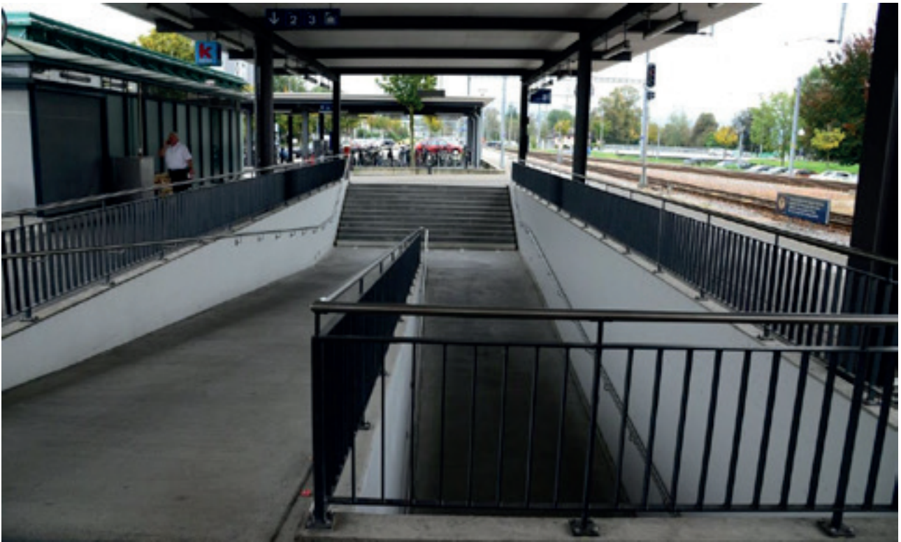
Figure 6 – Gare d'Uznach : dimensionnement généreux des liaisons verticales (escalier + rampe double)
