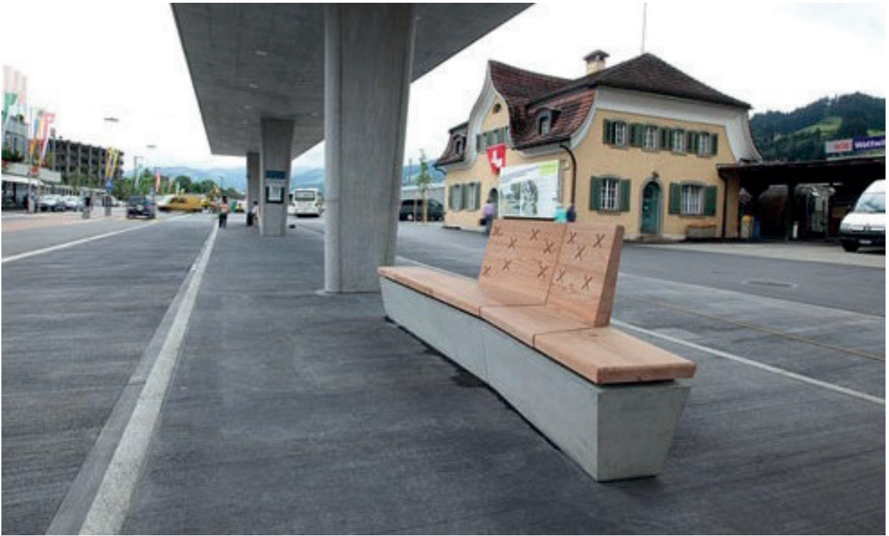
Figure 18 – Gare de Wattwil : un mobilier urbain soigné et en adéquation avec la fonction d'attente
