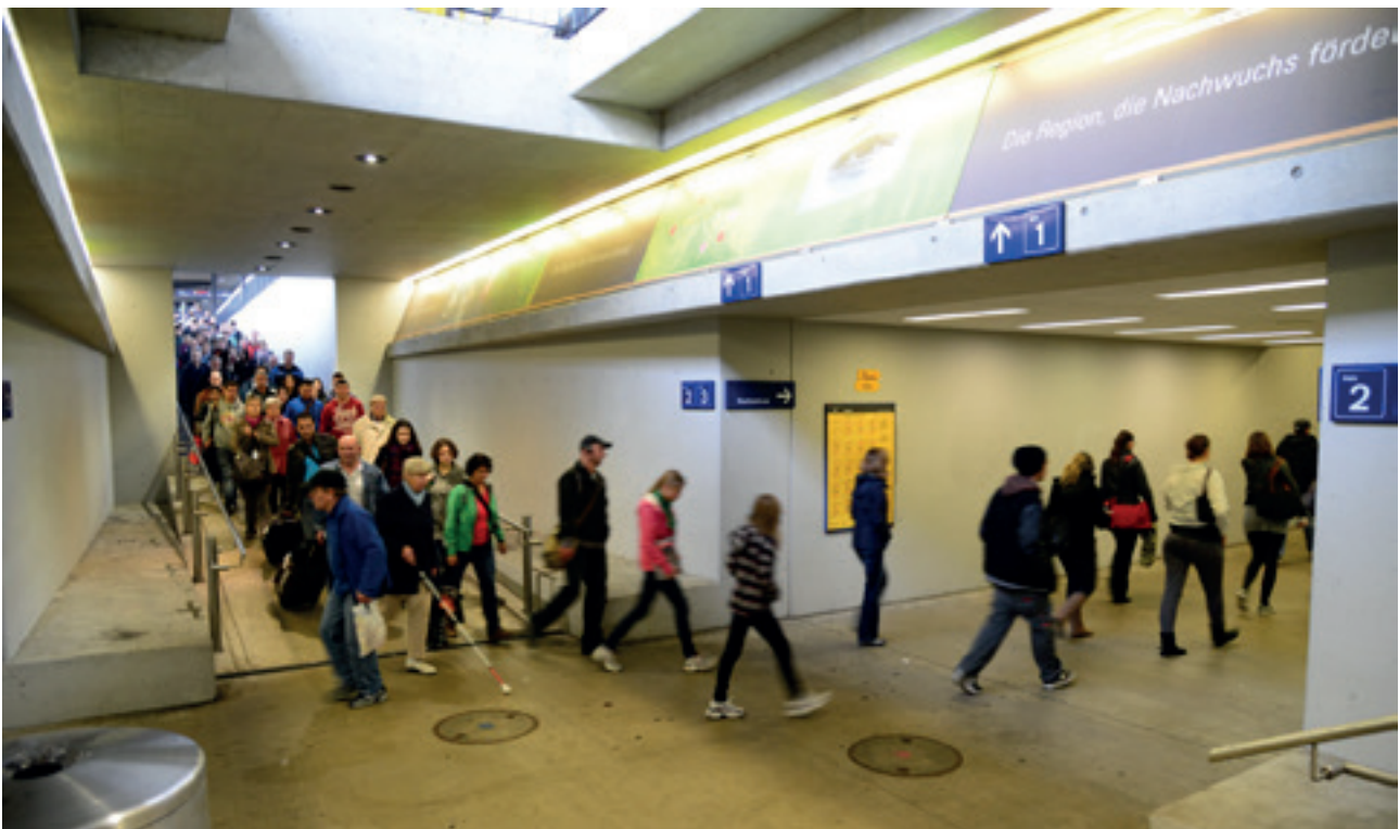
Figure 7 – Gare de Frauenfeld : amélioration de la visibilité au contact liaison verticale – passage inférieur en cassant les angles ; l'ouverture zénithale améliore la luminosité dans le passage inférieur
