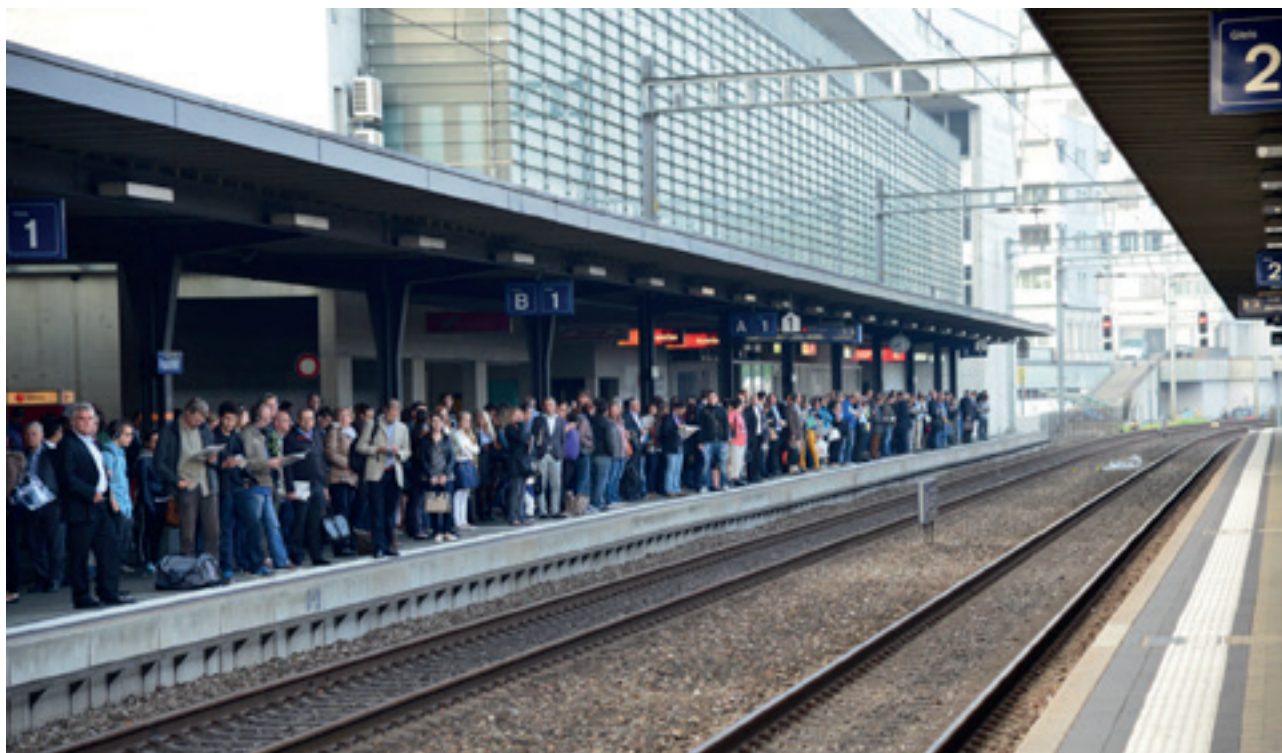
Figure 33 – Gare de Frauenfeld, quai 1 surchargé à l'heure de pointe du matin (sécurité et dimensionnement à long terme)
