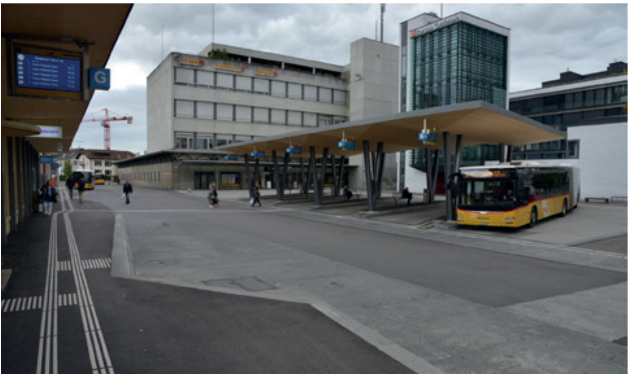
Figure 11 – Gare de Delémont : le quai bus en encoche (au premier plan) est fréquemment utilisés (très confortable pour l'exploitation et les phases de départ du quai)
