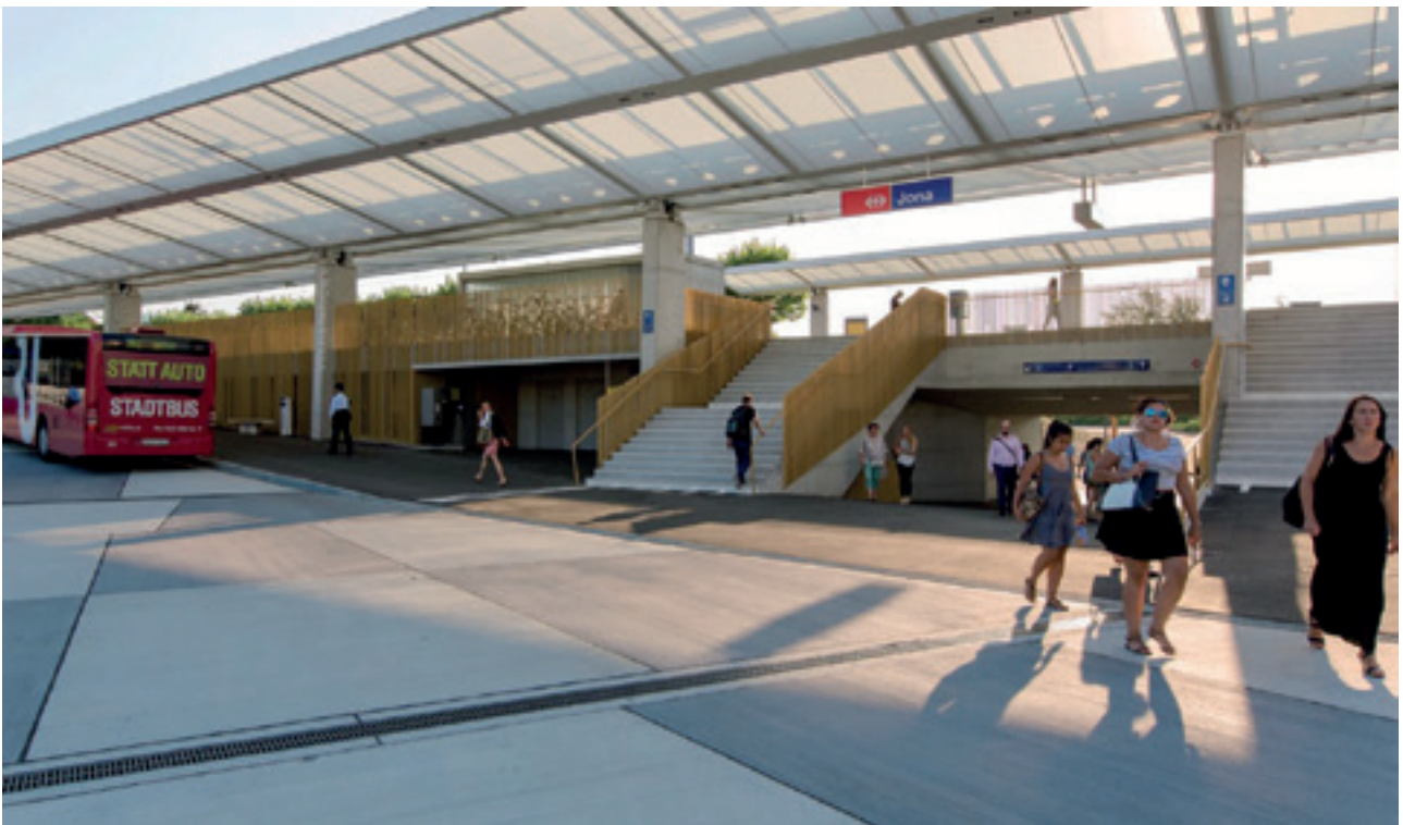
Figure 23 – Gare de Jona : l'espace interdit à la circulation est traité avec un revêtement différent, structurant l'ensemble du système
