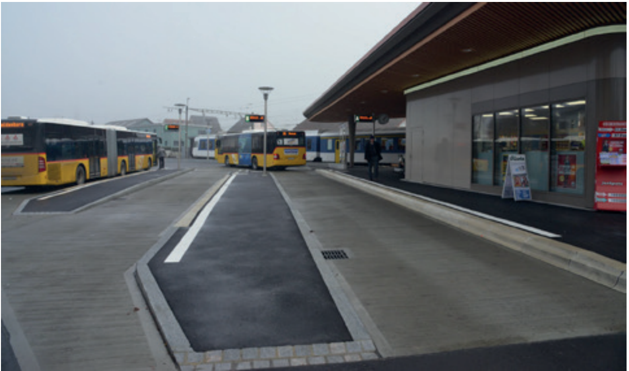
Figure 10 – Gare de Balsthal : simplicité des échanges quai-à-quai entre bus et train ; quais bus aménagés selon les exigences des PMR
