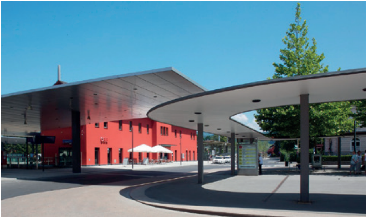
Figure 22 – Gare de Dornbirn : les couvertures affichent une légèreté architecturale et permettent d'abriter le parvis de la gare et les arrêts de bus ainsi que la liaison entre ces des sous-espaces
