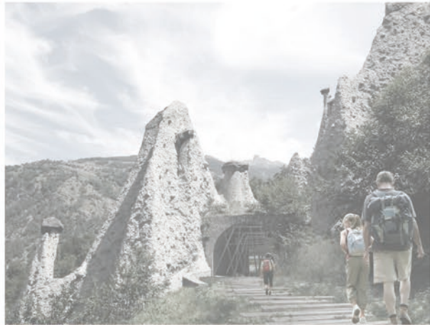
L'ancien tunnel de 1947 L'ancien tunnel de 1947, témoin existant du passé, permet la traversée à pied. Des madriers sont posés à même le sol. La végétation reprend le dessus. Le tunnel est mis à disposition de jeunes artistes. Ici une installation en lien à l'évolution des transports dans la vallée retraçant les différentes échelles et gabarits, sentier mulétier, carrosses, voitures.
