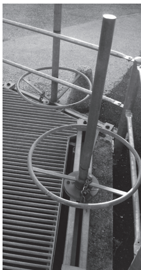
Schieber für die Verteilung des Wassers
