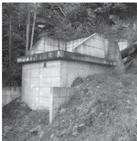
Hier verschwindet die Druckleitung in den Boden
