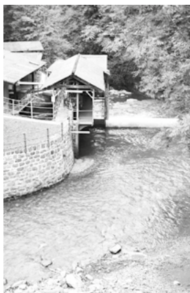
Prise d'eau du Pont du Pas
