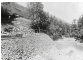
Construction du barrage en 1908
