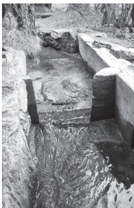
Bisse avec vanne pour diriger l'eau dans les canaux de distribution
