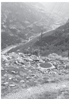
Ein Kontrollschacht – Hinweis auf die unterirdische Kanalisation
