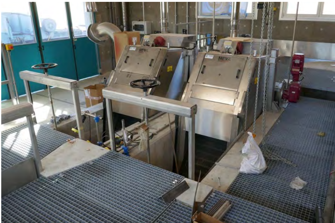
Abb. 22 : Neue Feinrechen der ARA Vétroz-Conthey
