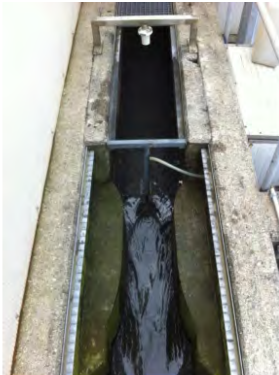
Abb. 6 : Venturi Durchflussmessung Zulauf ARA Collombey-Muraz
