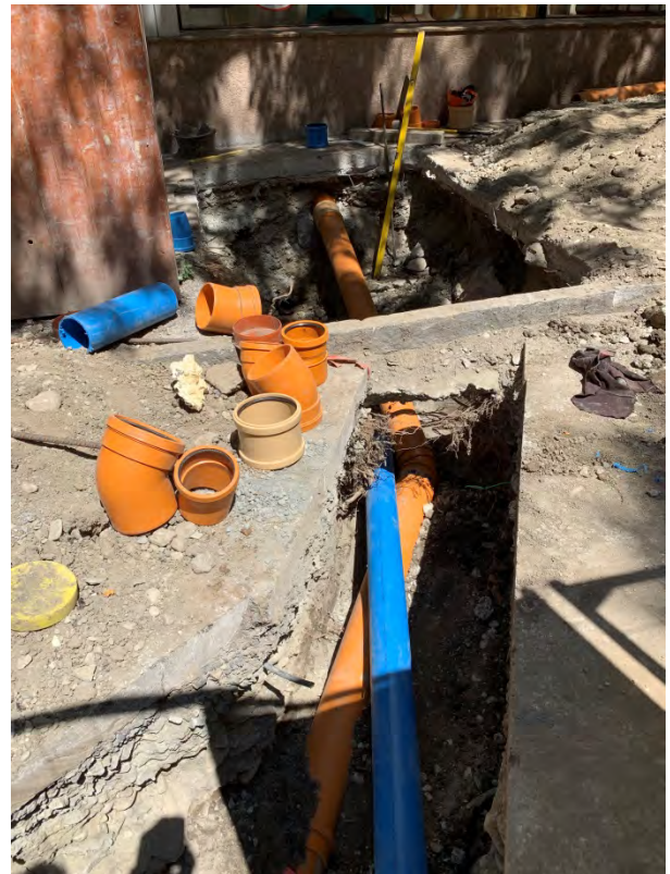
Abb. 10 : Bau eines Trennsystems in Sitten
