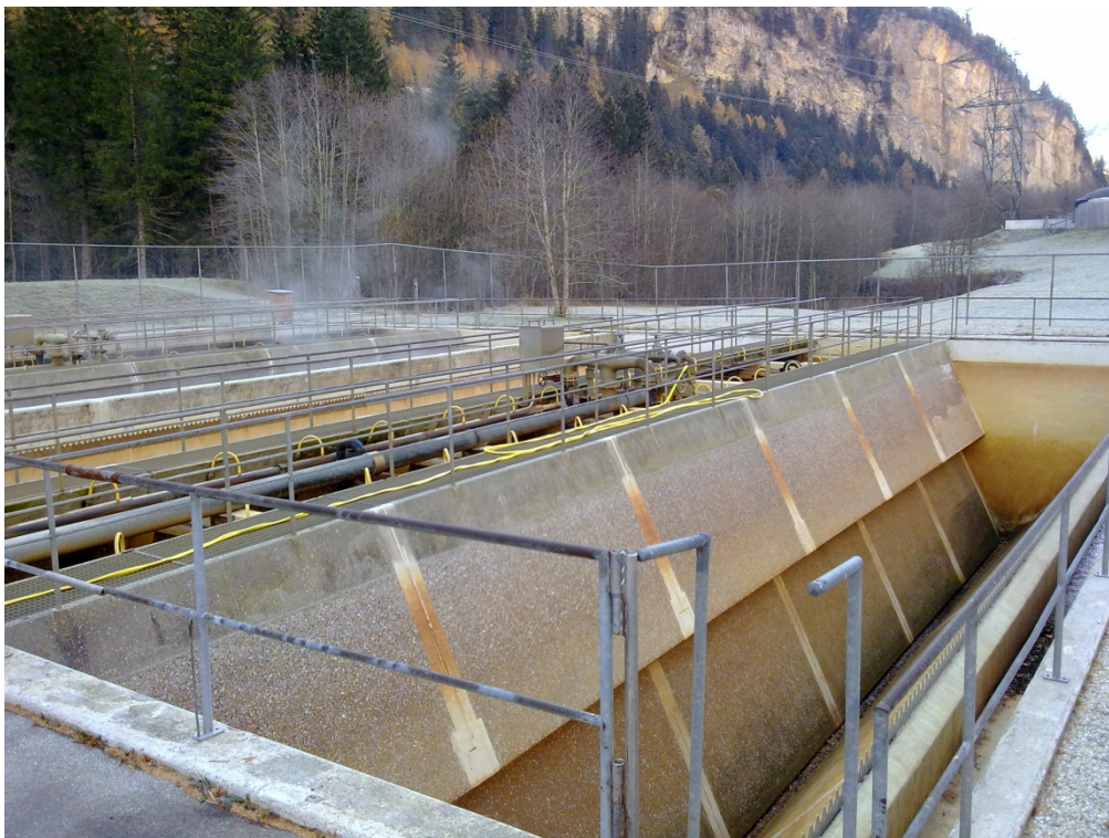
Abb. 5 : ARA Leukerbad – Nachklärbecken (Oxypacid)
