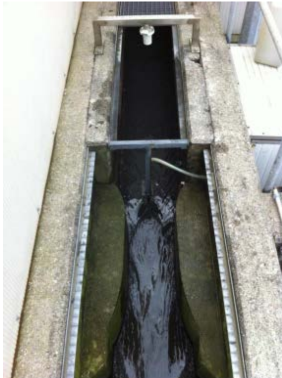
Abb. 8 : Venturi Durchflussmessung Zulauf ARA Collombey-Muraz
