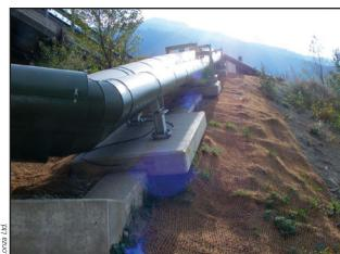
Die im Jahr 2010 eingeweihte Fern-dampfleitung, welche Prozessdampf von der Oberwalliser Kehricht-verbrennungsanlage Gamsen zur Lonza in Visp transportiert.
