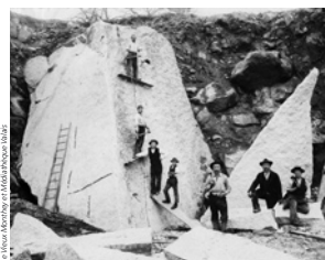
Exploitation d'un bloc de granite dans la carrière Guidetti Constantin vers 1890-1910
