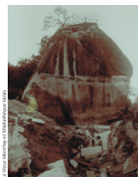
Travaux d'approche en vue de l'exploitation de la Pierre des Marmettes
