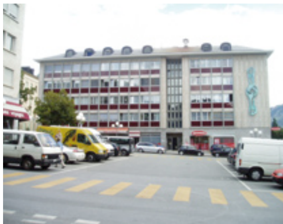
Ce bâtiment administratif de Sion héberge notamment le Service de la protection de l'environnement.
