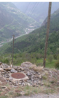
Un puits de contrôle - indice de la canalisation souterraine
