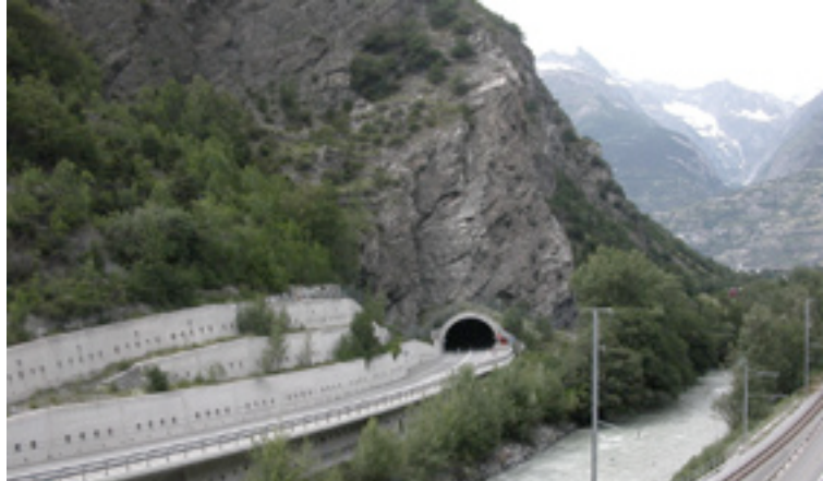
Tunnel de la vallée des Vièges
