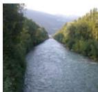
Wasserbau nach alter Art: schnurgerade Abflussrinnen ohne angrenzende Flussauen
