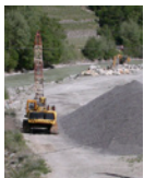
Ein Seilbagger ist auf dem Weg zur Kiesentnahme aus dem Fluss.
