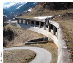
Galerie de protection contre les avalanches sur la route de Mâche
