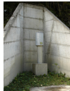
Certaines chambres d'aération, servant à faciliter l'écoulement libre des eaux dans la conduite, ont dû être protégées des chutes de pierres par un ouvrage en béton.
