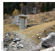
Porte d'accès à la chambre de captage
