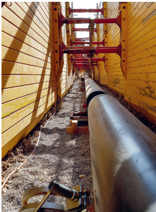
In Bellevue (GE) musste die Erdgasleitung drei Meter tiefer verlegt werden.
