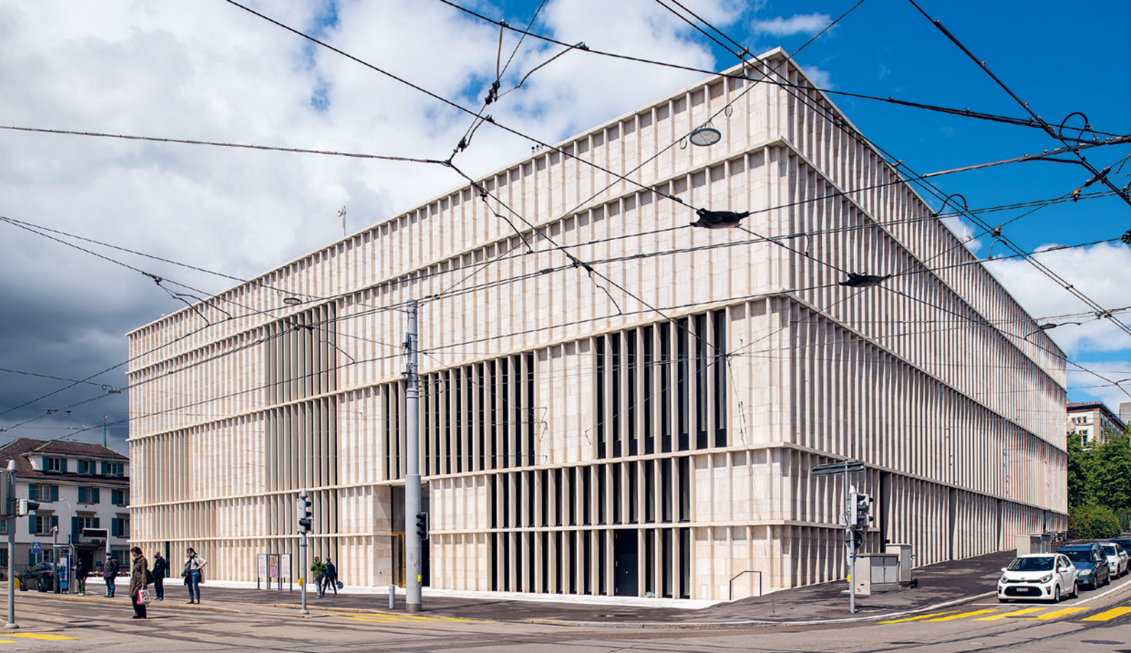
Das Zürcher Kunsthaus wurde mit Recyclingbeton gebaut.
