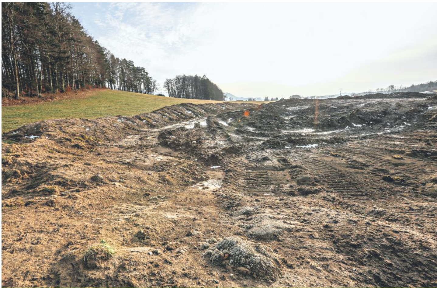
Remblayer une parcelle est un travail complexe; s'il n'est pas bien maîtrisé, la compaction, le tassement, voire l'enfouissement de déchets et les atteintes à la fertilité du sol sont inévitables.
