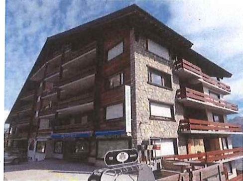
Vue angle Sud-Ouest
