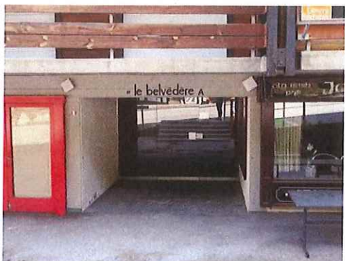
Entrée principale du bâtiment
