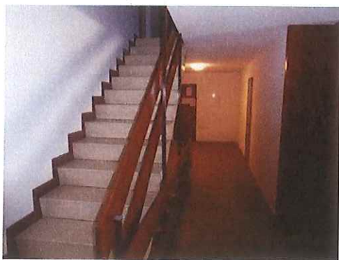
Dégagement / cage d'escaliers
