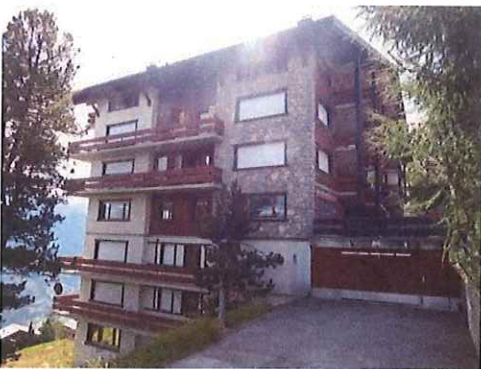
Vue angle Nord-Ouest
