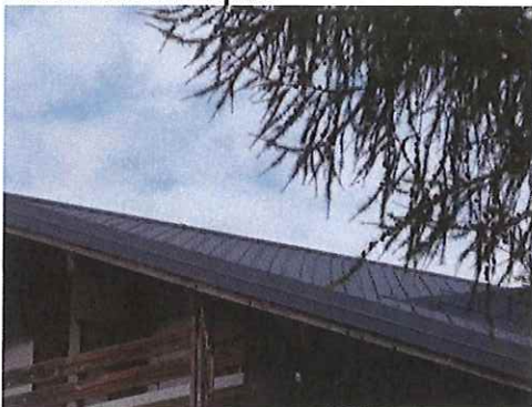
Couverture en ardoises de type « Eternit »
