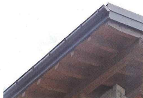
Ferblanterie en cuivre / avant-toits bois lamé, charpente bois
