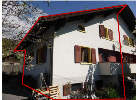
Vue angle Sud-Ouest
