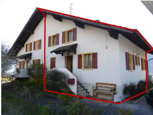
Vue angle Nord-Ouest
