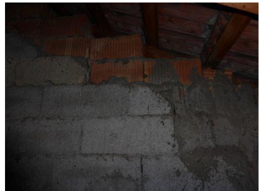
Mur de façade en maçonnerie
