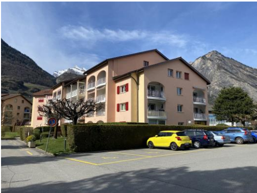
Vue angle Sud-Ouest
