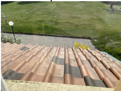
Couverture en tuiles mécaniques
