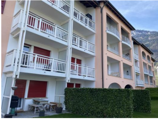
Vue façade Est
