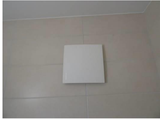
Ventilation mécanique (WC séparé)
