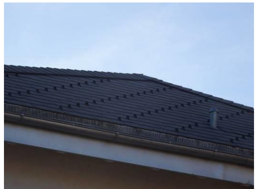
Couverture en ardoises de type « Eternit »
