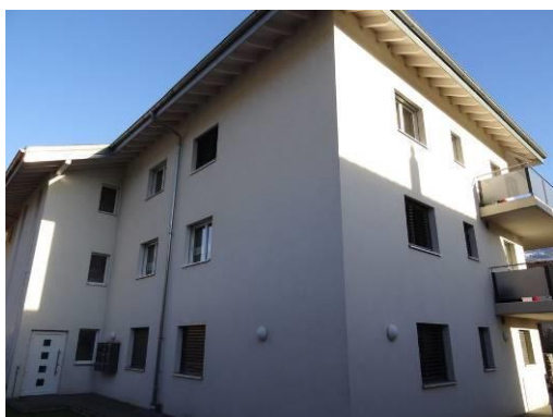
Vue angle Nord-Ouest
