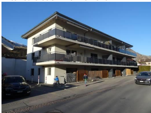
Vue angle Sud-Ouest
