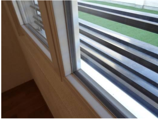
Fenêtre en PVC avec vitrage isolant | Store à lamelles en aluminium thermolaqué
