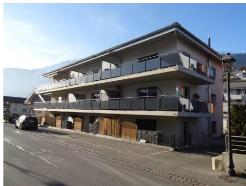
Vue angle Sud-Est
