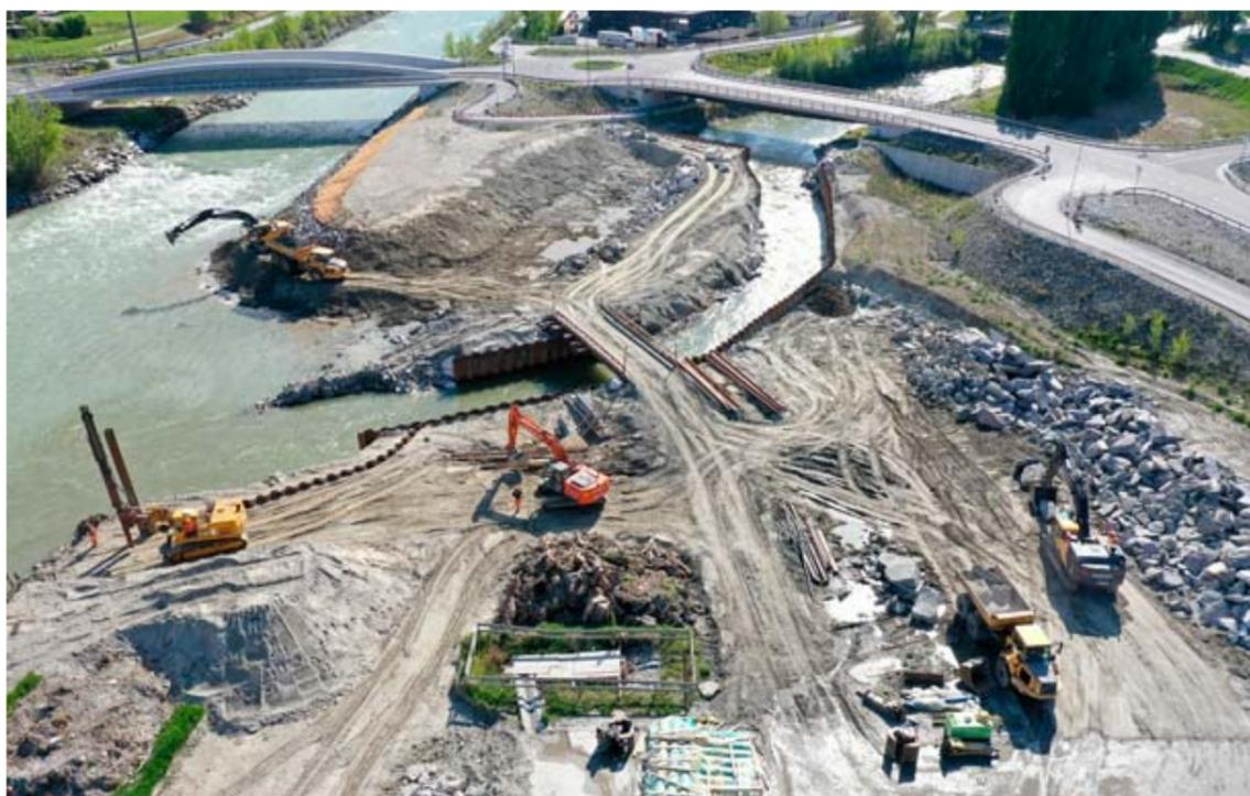
La première mesure prioritaire mise en œuvre dans le cadre du projet de 3<sup>e</sup> correction du Rhône est celle de Viège. Ici, les travaux à l'embouchure de la Vispa. CANTON DU VALAIS
