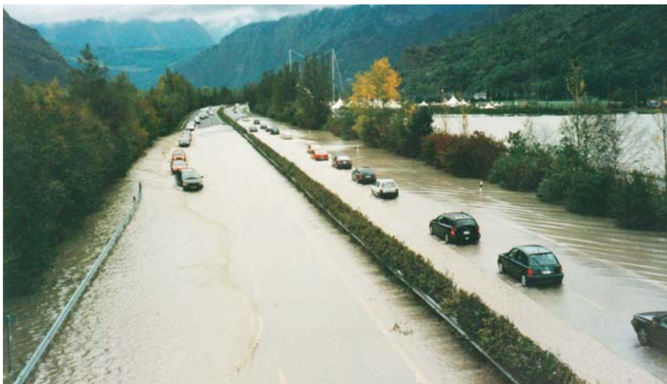
L'autoroute inondée par le fleuve en crue, à la hauteur d'Evionnaz. (Image mise à disposition dans le cadre de l'appel à photo) CHRISTIANE RICHARD
