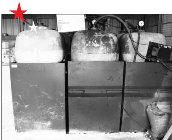
*Bei dieser Anlage wurde vergessen, die Pumpe auszuschalten, worauf der Druck schliesslich zum Bersten der Schlauchleitung führte. Treibstoff ergoss sich auf den Kiesboden, in die Entwässerungsleitung unterhalb des Gebäudes und gelangte schliesslich in ein Gewässer. Durch das Abschürfen der verschmutzten Erdschichten, das Ausspülen der Abwasser- und Frischwasserleitungen und das Errichten einer Sperre zum Schutz des Gewässers wurden Kosten in der Höhe von 17'000 Franken verursacht.*
