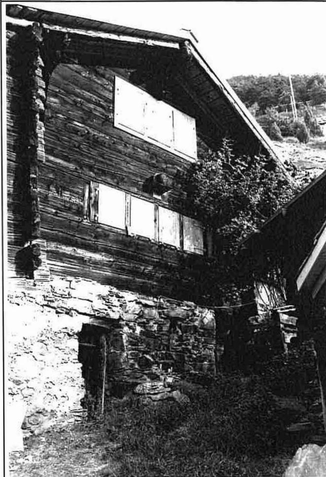
**Beschrieb:** Wohngebäude, nicht genutzt, Bruchstein-Mauersockel, teilweise verputzt, Blockaufbau, 2-geschossig, im 2. OG Fenster vergrössert, Dach mit Profilblech gedeckt
