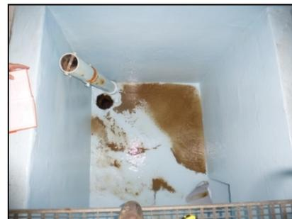
Trop-plein de la chambre, avec dépôts de sable et de limon
