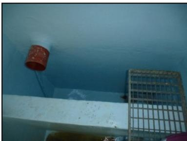
Arrivée d'eau dans la chambre de contrôle (PVC Ø 155 mm)
