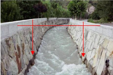
Die Flächen der Ufermauern sind nicht bei den Gewässern zu definieren. Die Ufermauern sind bei den anschließenden Bodenbedeckungsarten aufzunehmen. (siehe auch 'uebrige\_befestigte')
