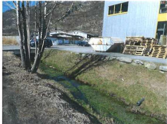
**Abbildung 6 und 7: Italienergraben.** Der Italienergraben verläuft gleichförmig und weist ein monotones Trapezprofil auf. Der Gewässerraum ist von Gebäuden und Strassen begrenzt. Er mündet beim Tenniscenter in den Grossen Graben.
