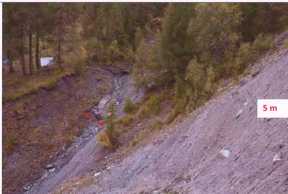
Tronçon TDA03, amont
