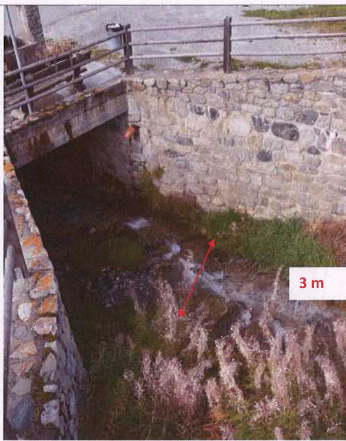
Tronçon SAG04, aval
