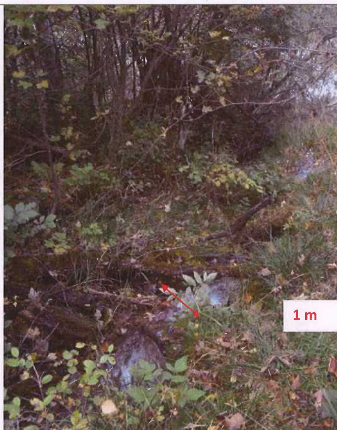
Tronçon LTD02, aval
