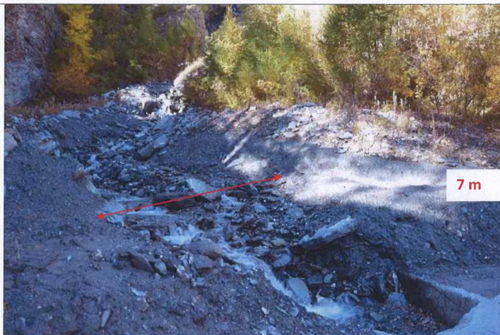
Tronçon MAR01, amont
