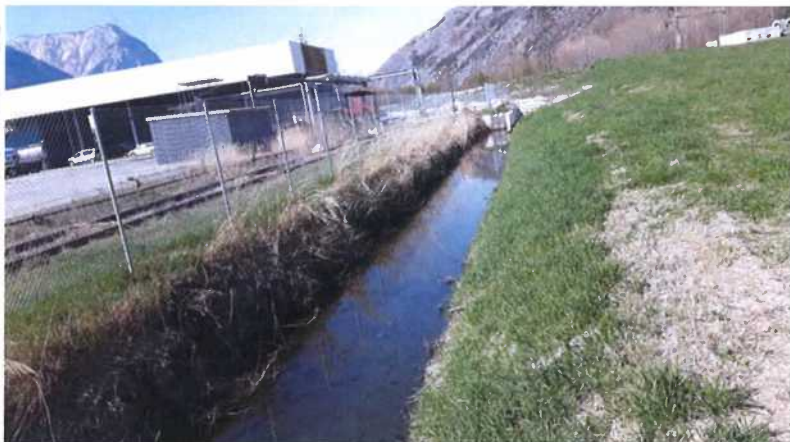
Foto kanalabwärts in Richtung QP PUT 2
