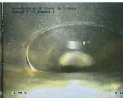
Tuyau déformé, limitant la capacité hydraulique
