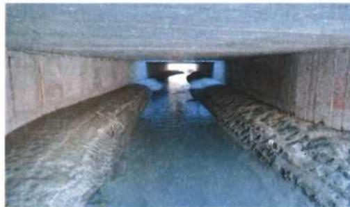
Figure 8 Canal de Bramois - le passage sous l'autoroute est considéré comme enterré (ERE enterré/recouvert).
