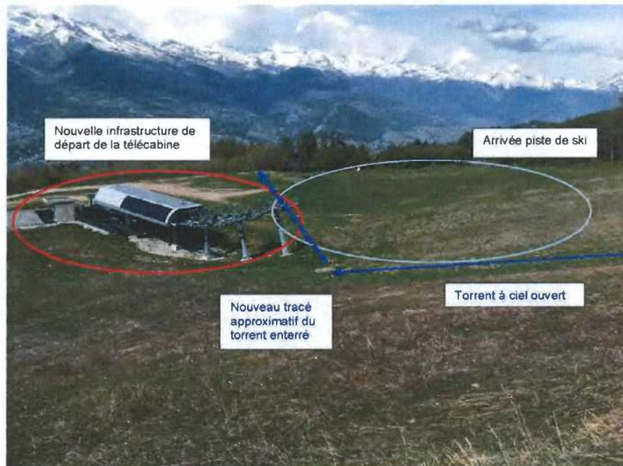
Figure 5 : Proposition de changement de tracé de la conduite du torrent de Salins
